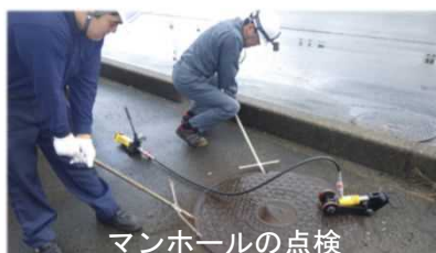
マンホールの点検
