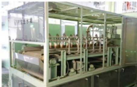
【横手処理センター 汚泥脱水設備更新】
